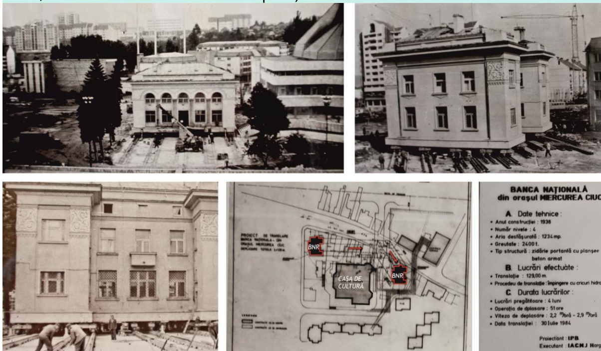
FIGURA 12 – Banca Națională a României, azi Banca Carpatica, municipiul Miercurea Ciuc, cod LMI: HR-II-m-B-12740 – Operațiunea de translatare a clădirii
